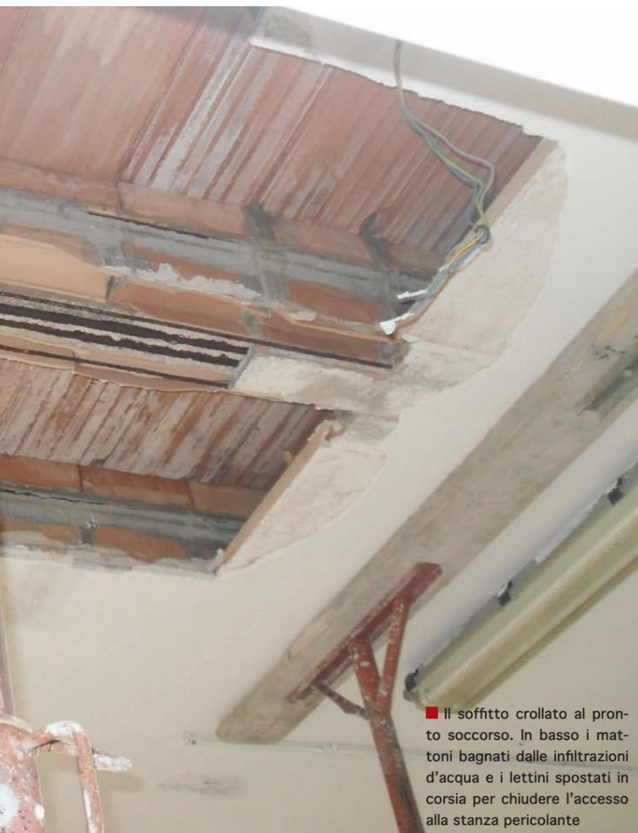
■ Il soffitto crollato al pronto soccorso. In basso i mattoni bagnati dalle infiltrazioni d'acqua e i lettini spostati in corsia per chiudere l'accesso alla stanza pericolante
